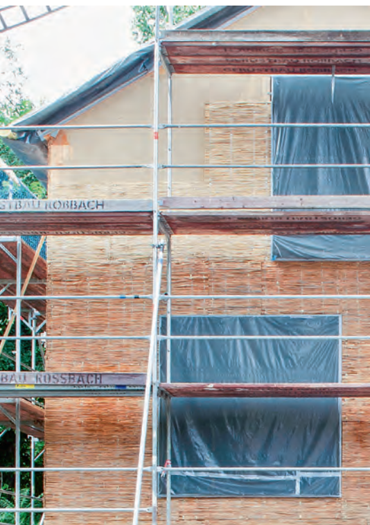
Schilfrohrplatte als Putzträger
